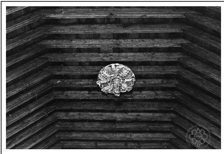
Techumbre en madera o alfarje del Templo de la Tercera Orden. Fotografía de la CNMH-INAH, DCLX-64.
