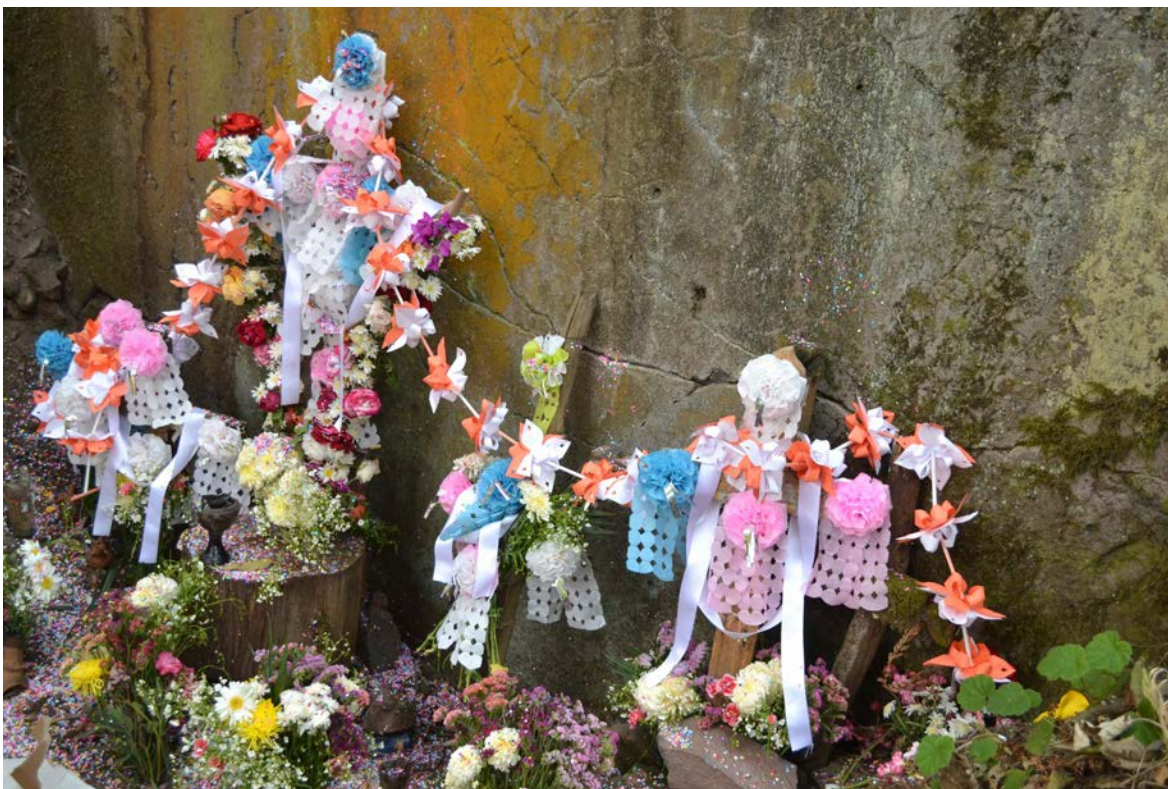
Foto 76. Templo de Santo Domingo. 2014. Espacio por donde emerge la potencia de la culebrina de agua y viento. Véase las cuarteaduras de la roca.
